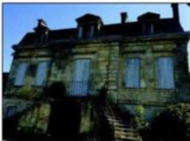
Les travaux de restauration de la chartreuse débuteront à l'automne.
